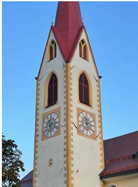
Der renovierte Kirchturm in Reischach.
